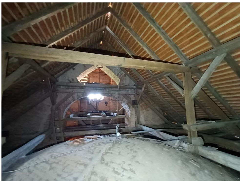
Potkrovlje_ pogled prema zvoniku
